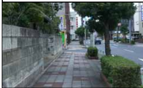
視覚障害者誘導用ブロック未整備区間の状況
