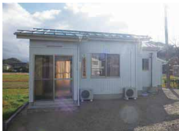
コミュニティ施設整備補助事業により整備された自治集会所
