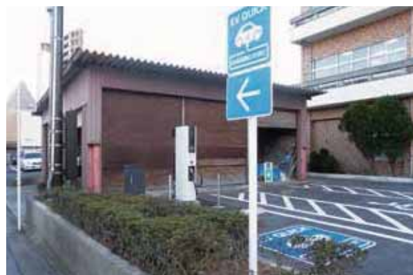
市役所第2庁舎に設置された電気自動車用急速充電器
