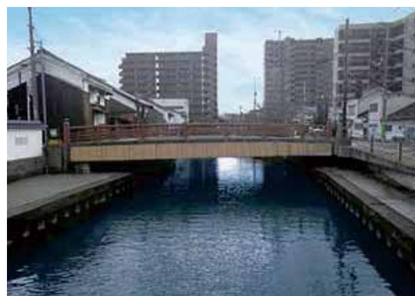
橋りょうの補修(天神橋)
