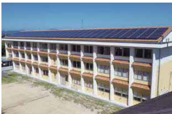
市有施設の屋根貸しによる太陽光発電普及事業
