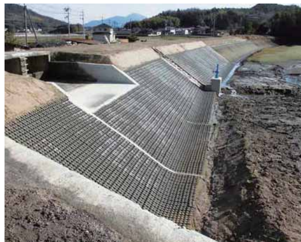
ため池の整備（古市大池）
