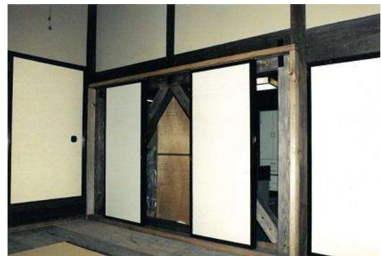
木造建築における耐震補強(後藤家住宅)
