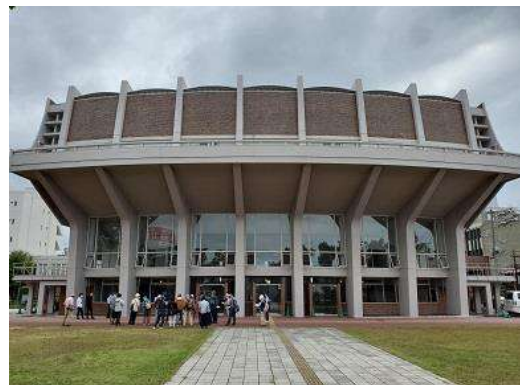
米子市公会堂（昭和 33 年）
