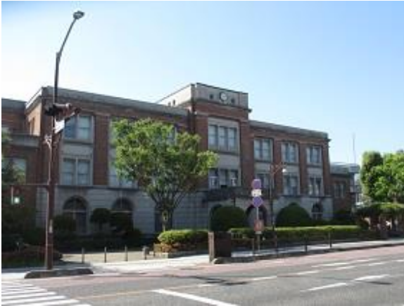
米子市役所旧館（市有形文化財）
