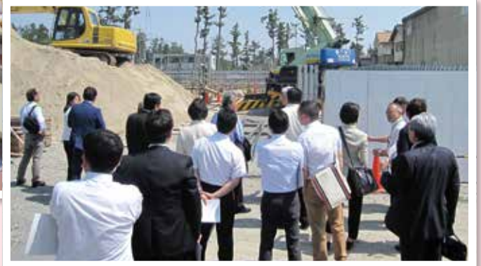
米子市弓浜コミュニティ広場及び米子市弓浜地域老人福祉センター建設現場の視察のようす（平成27年5月8日）
