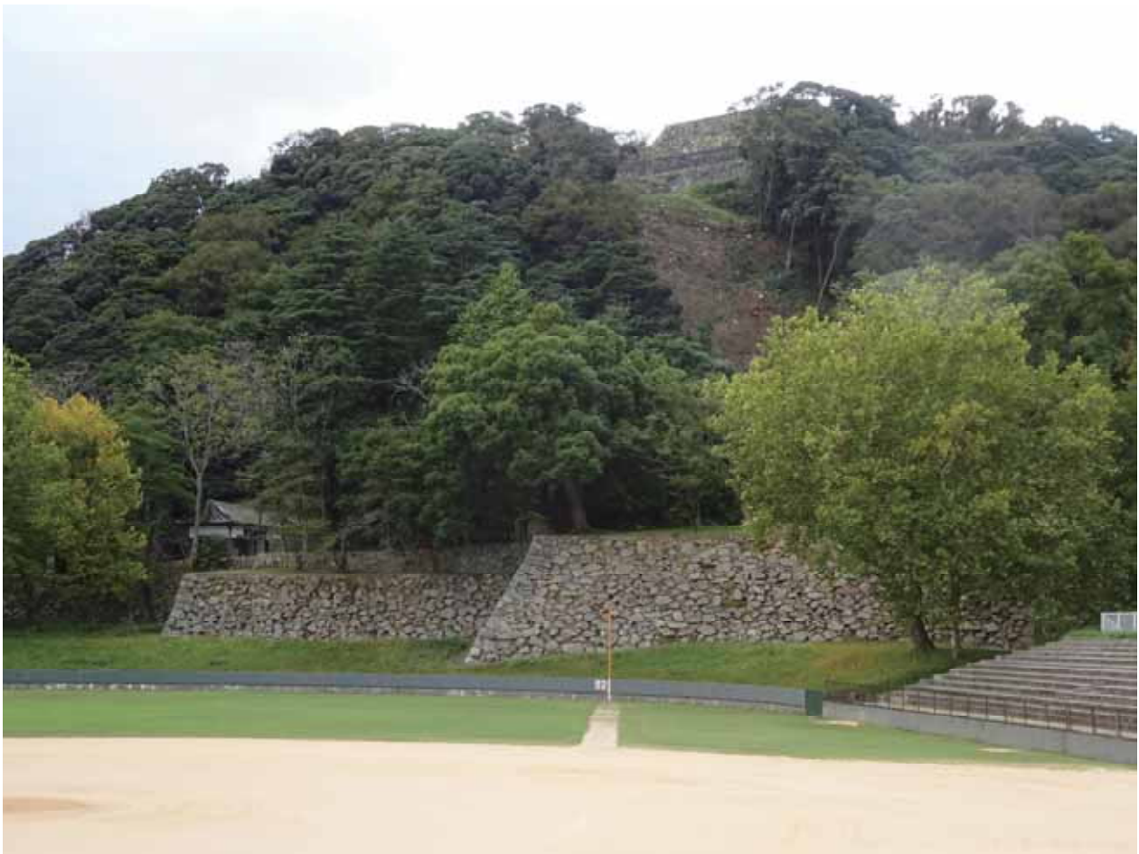
三の丸（湊山球場）から見る二の丸高石垣と天守石垣 上：樹木伐採前（平成 30 年(2018)7 月） 下：伐採後（同年 11 月）
