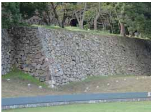
二の丸石垣 打込みハギ、布崩し積み
