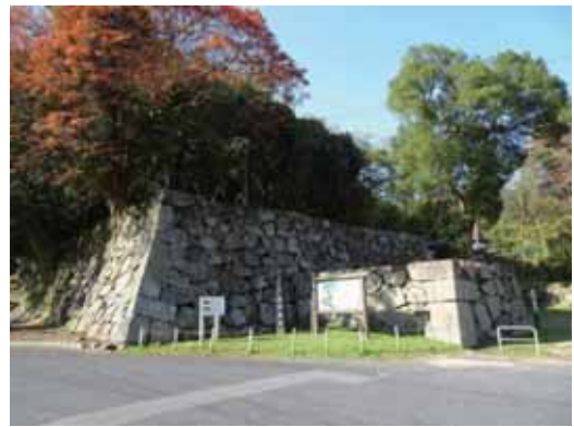
二の丸石垣 打込みハギ、布崩し積み 隅角部:算木積み
