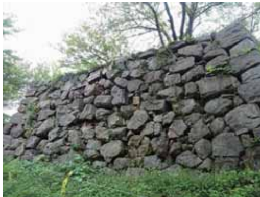
水手御門櫓跡石垣 打込みハギ、布崩し積み
