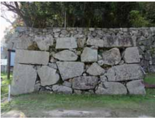
二の丸石垣 (桁形) 打込みハギ、布崩し積み 隅角部:算木積み
