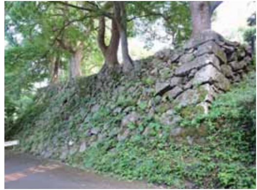
二の丸石垣 打込みハギ、布崩し積み 隅角部:算木積み 石垣天端際に樹木
