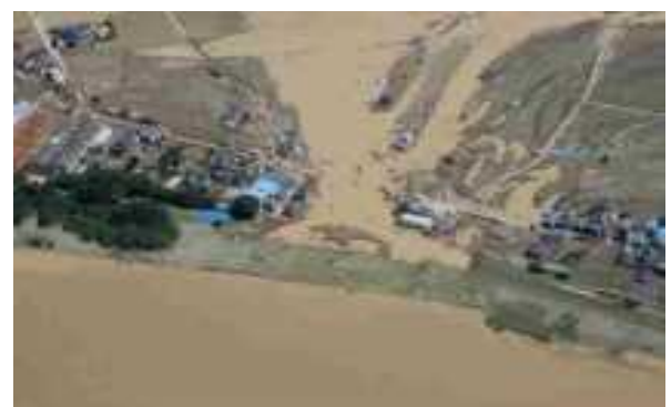
堤防決壊による家屋の流失(鬼怒川)
