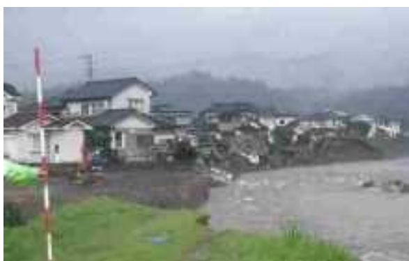
河岸侵食による家屋の倒壊(花月川)
