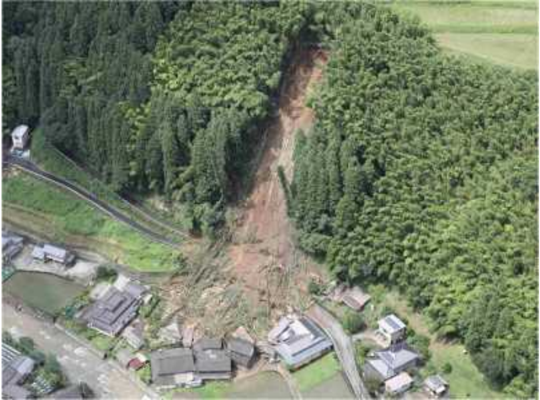
写真 2 土砂災害による建物被害の例（大分県日田市令和 2 年 7 月）
