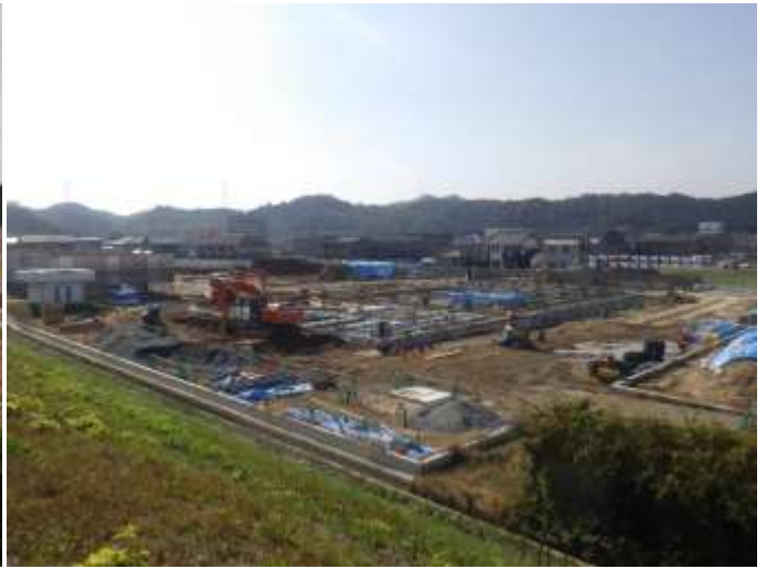
基礎コンクリート打設(H28 年 11 月)
