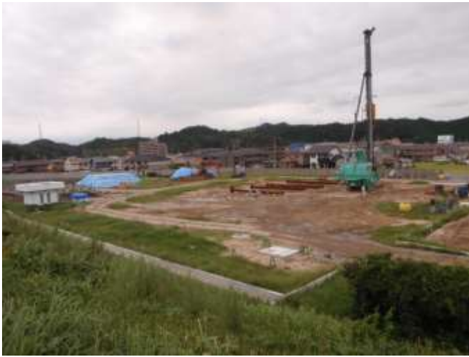
基礎杭建込(H28 年 9 月)
