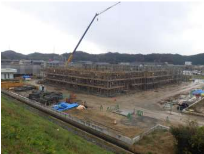
1 階躯体工事 (平成 29 年 1 月)
