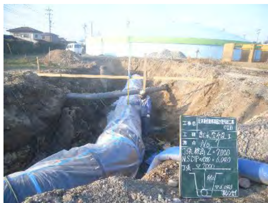
中央配水管（車尾水源地内）
