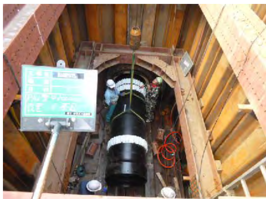
中央配水管（古地井手川推進工事）
