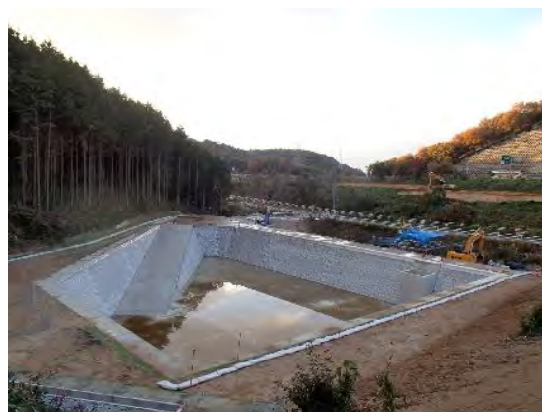
雨水洪水調節池
