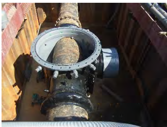
中央送水管分岐（ \phi 800 \times \phi 800 ）
