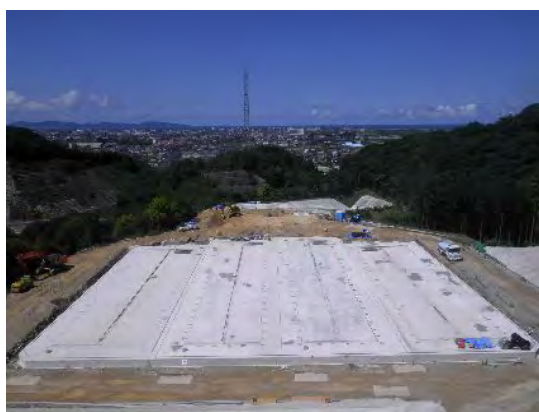
基礎コンクリート
