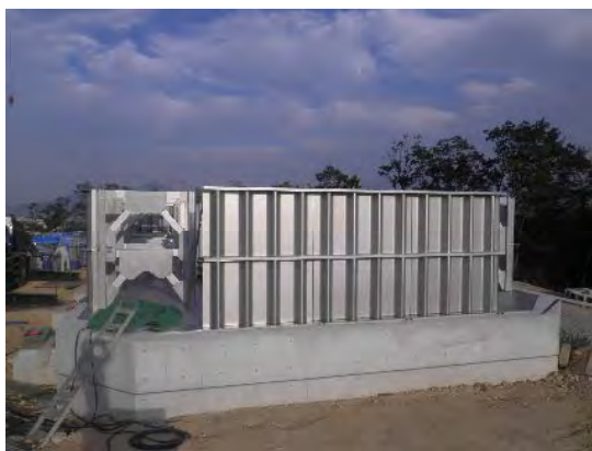
南部配水池横板及び内部補強 (1 段目)
