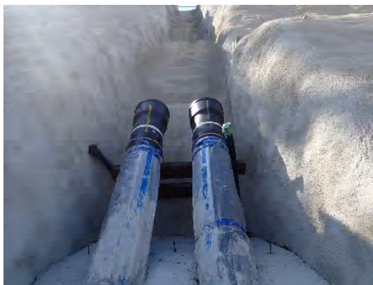
南部送配水管（法面配管）
