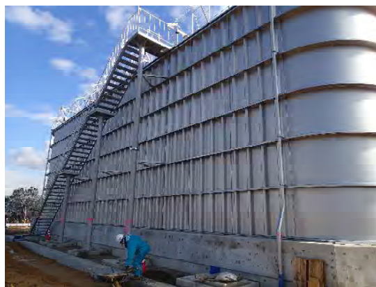
南部配水池完成
