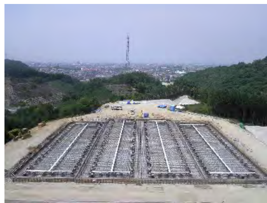
基礎内鉄筋配置
