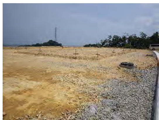
南部配水池設置面
