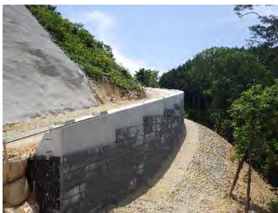
南部管理道擁壁工事
