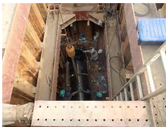
中央配水管（米川下推進工事）
