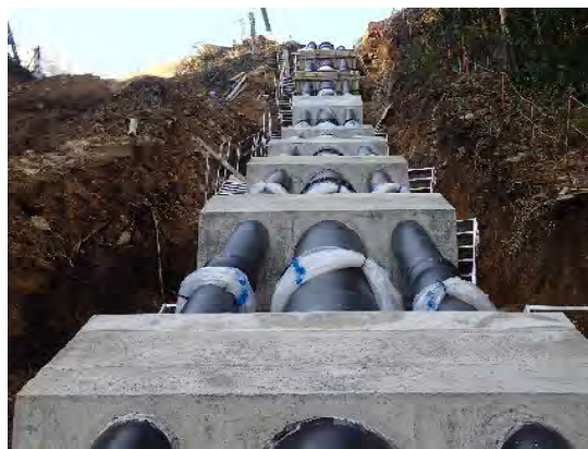
中央配水管北側斜面配管
