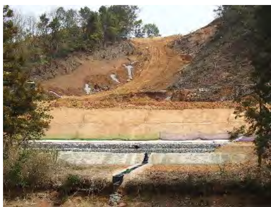
切土・盛土工事
