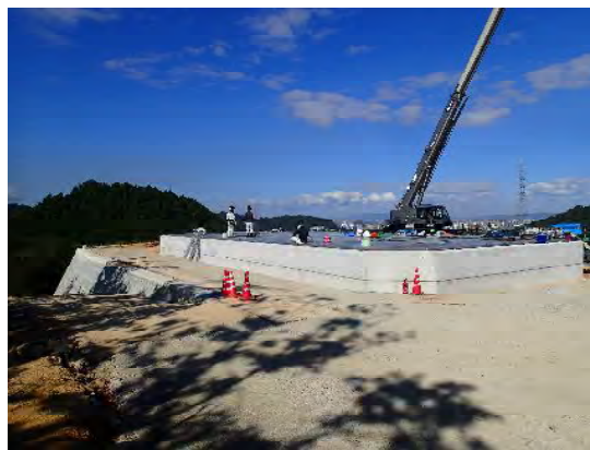
南部配水池底板設置 (SUS304)
