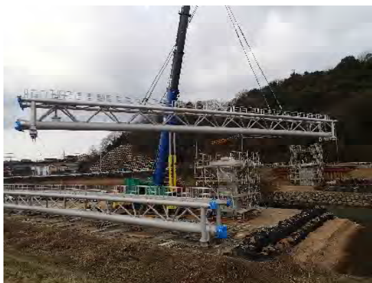
水管橋架設状況
