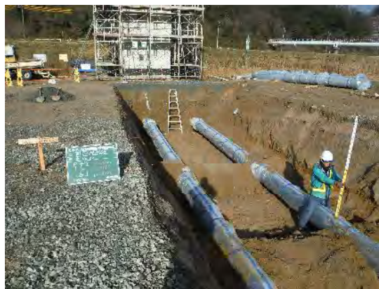
南部送配水管布設
