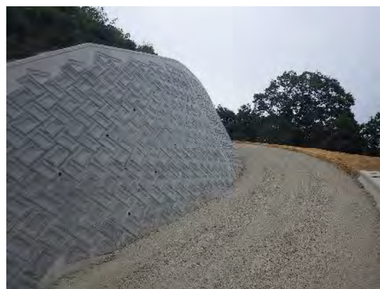
南部管理道法面保護工
