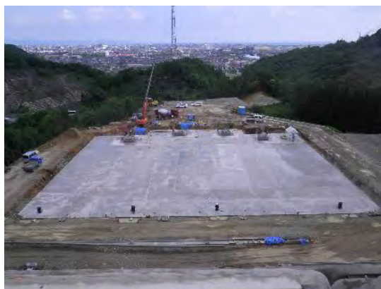
中央配水池基礎ベースC o
