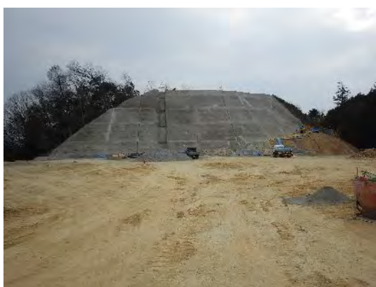
中央配水池設置面
