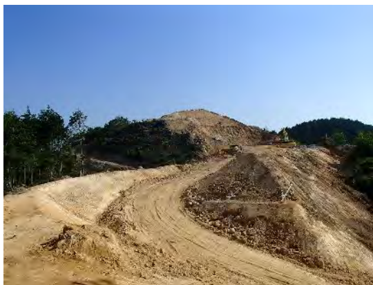
管理道建設及び法面切土
