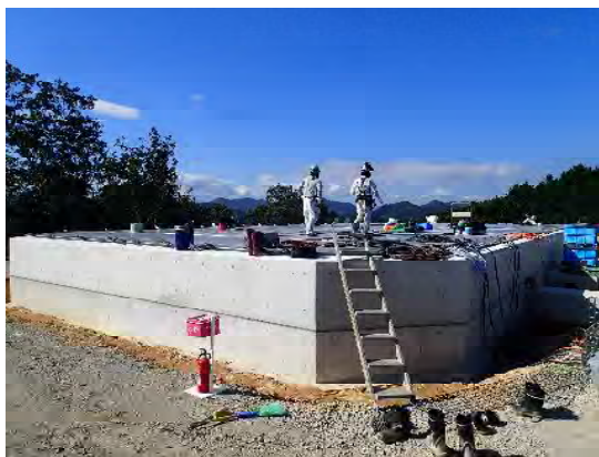
南部配水池基礎工事
