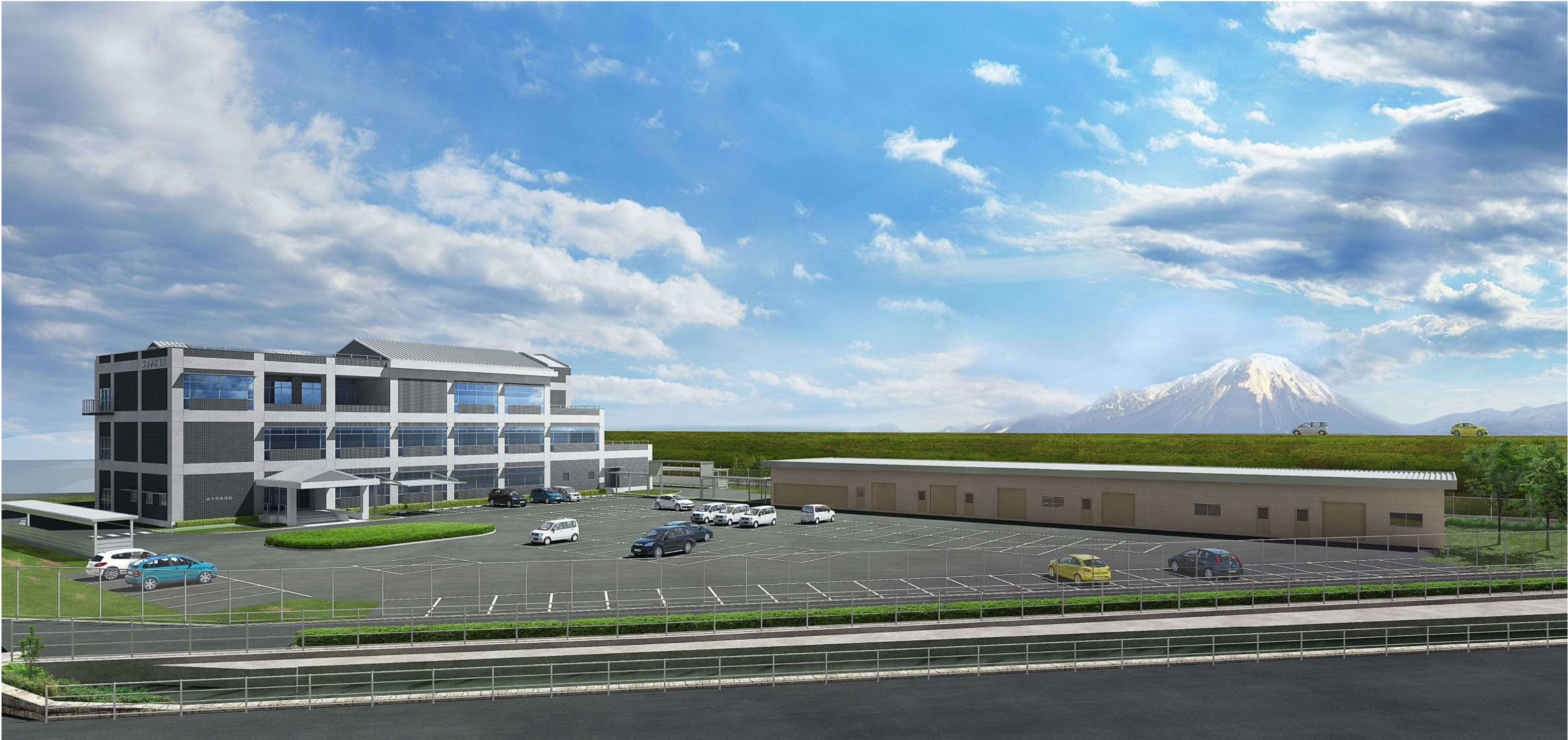
米子市水道局新庁舎
