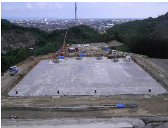
中央配水池基礎ベースC o
