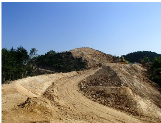
管理道建設及び法面切土
