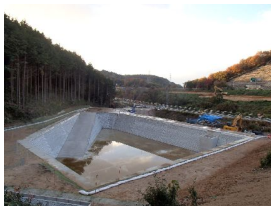
雨水洪水調節池
