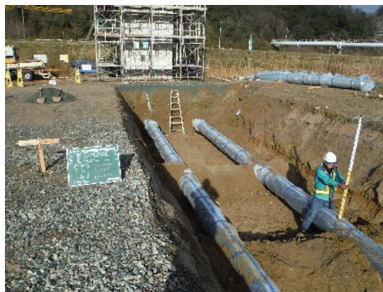
南部送配水管布設
