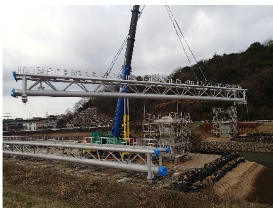
水管橋架設状況
