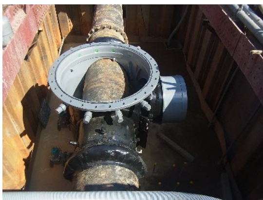
中央送水管分岐（ \phi 800 \times \phi 800 ）
