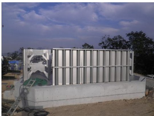
南部配水池横板及び内部補強 (1 段目)
