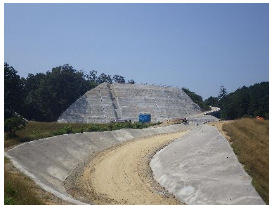
管理道及び法面現況
