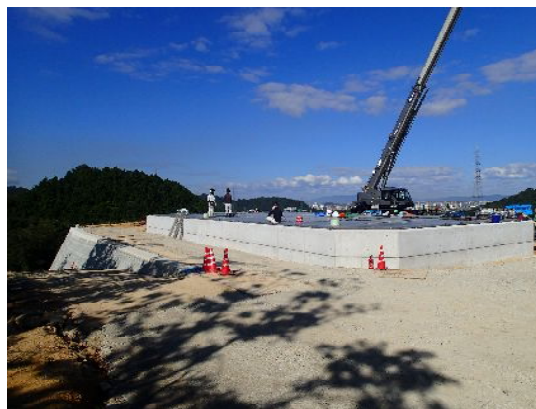
南部配水池底板設置 (SUS304)
