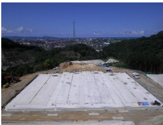
基礎コンクリート
