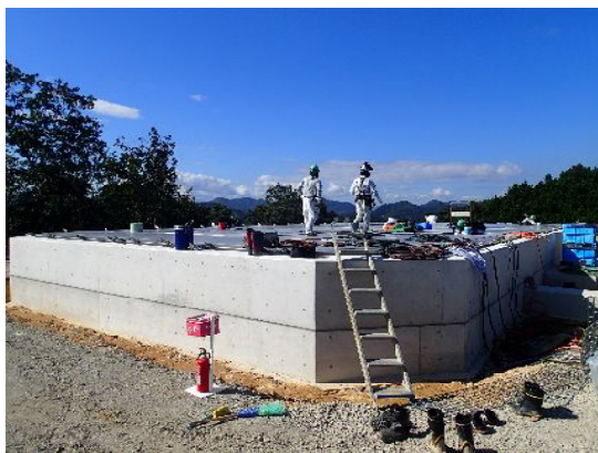
南部配水池基礎工事
