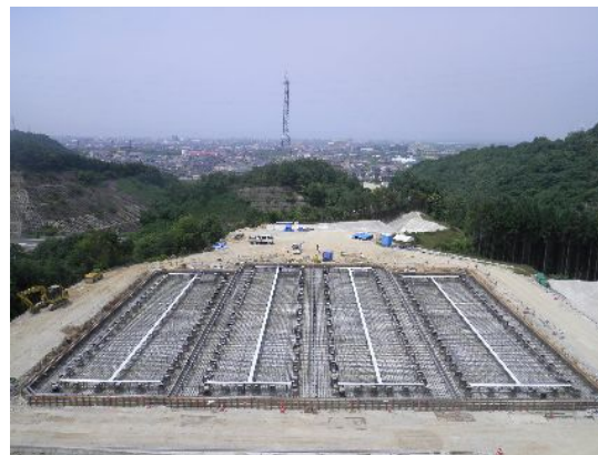
基礎内鉄筋配置
