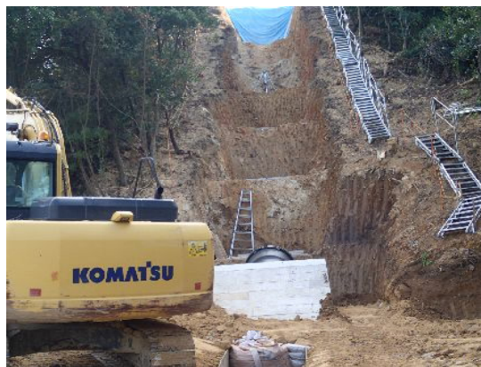
中央配水管北側斜面配管
