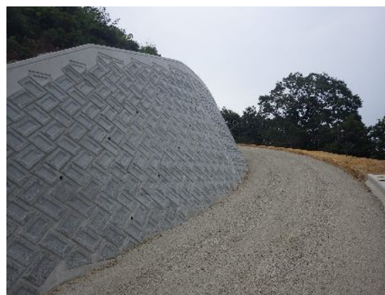
南部管理道法面保護工
