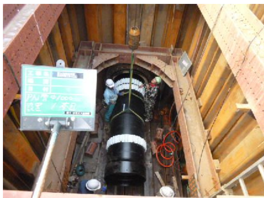
中央配水管（古地井手川推進工事）
