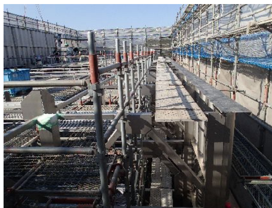
南部配水池内部組立状況
