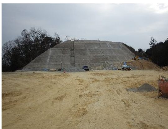
中央配水池設置面
