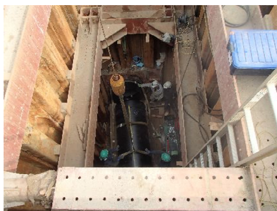
中央配水管（米川下推進工事）
