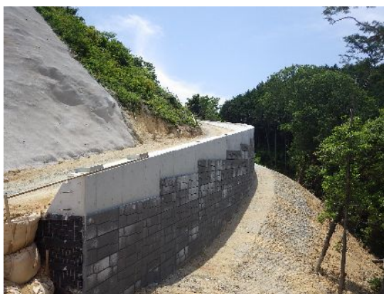
南部管理道擁壁工事
