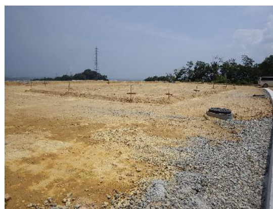
南部配水池設置面
