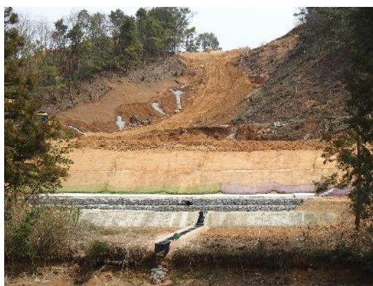
切土・盛土工事
