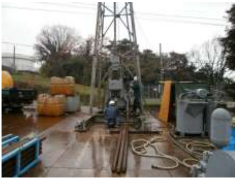
ボーリングマシン設置
