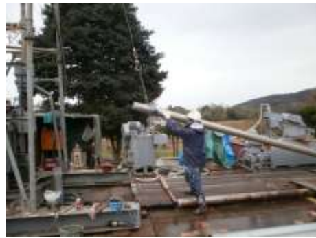
ボーリング作業中
