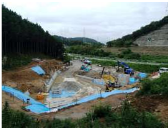
雨水洪水調節池
