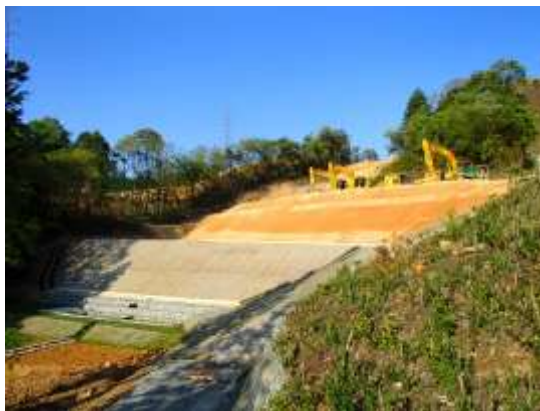
土質改良工事
