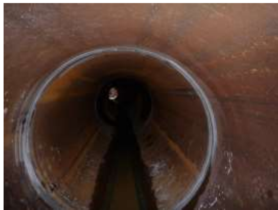
米川下推進工事（推進管 φ 1400mm）
