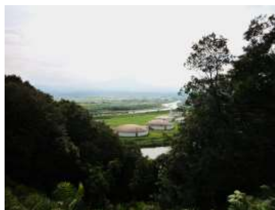
大山・戸上水源地を望む
