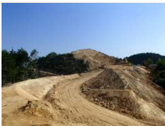
管理道路設置工事
