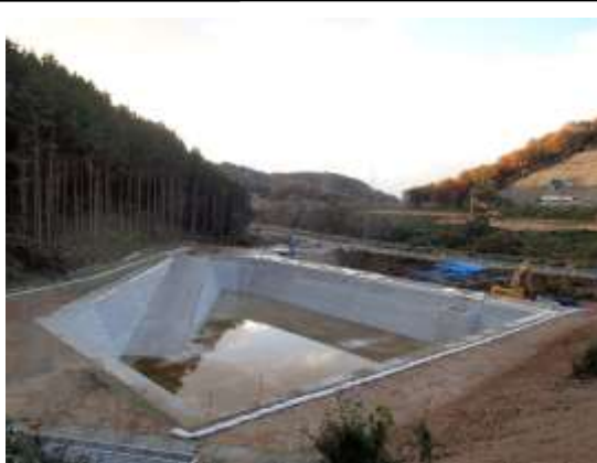
雨水洪水調節池
