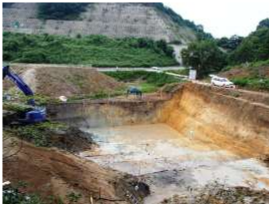
雨水洪水調節池
