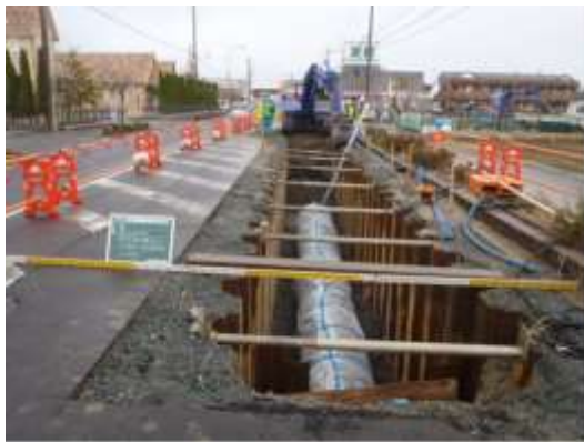
観音寺新町内布設状況 (NSDIP φ 1000mm)
