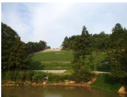
北側法面工事
