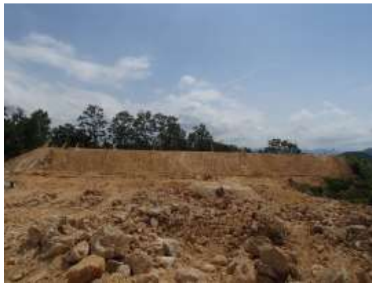
南部配水池設置箇所整地工事
