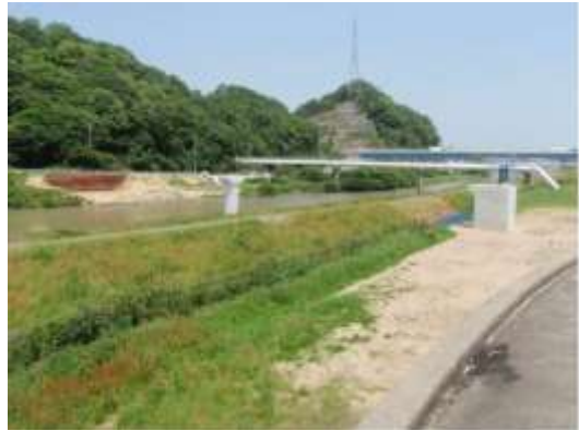
下部工（左右橋台・橋脚）
