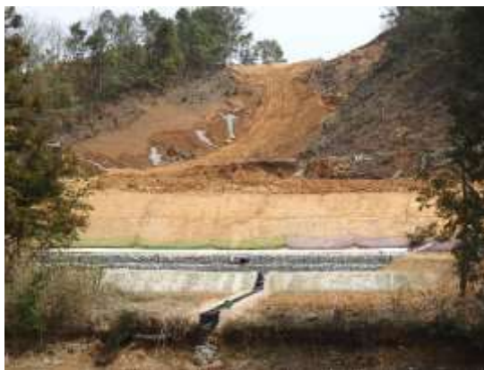
切土及び盛土工事
