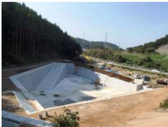
雨水洪水調節池
