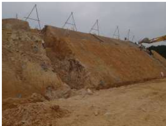
南部配水池の法面工事
