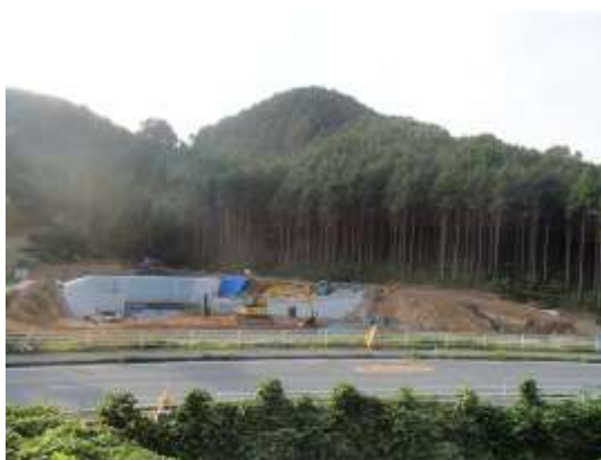
市道側から見た雨水洪水調節池
