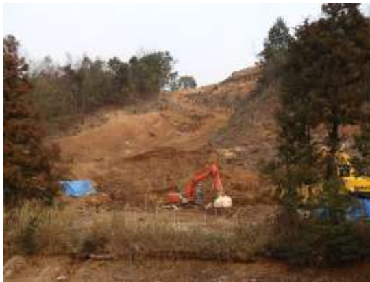
土質改良工事
