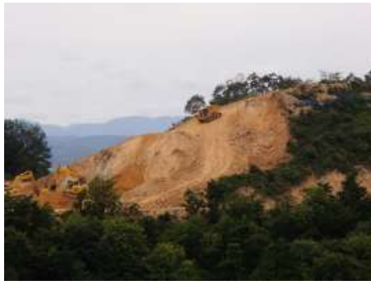
南部配水池法面切土工事
