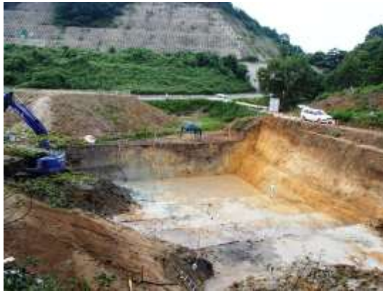
雨水洪水調節池
