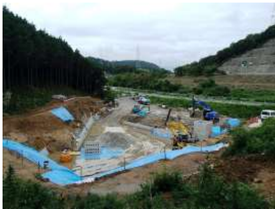
雨水洪水調節池
