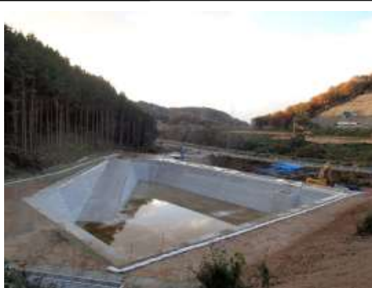
雨水洪水調節池
