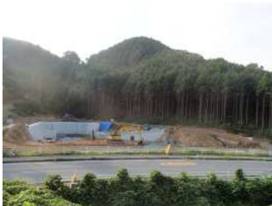
市道側から見た雨水洪水調節池
