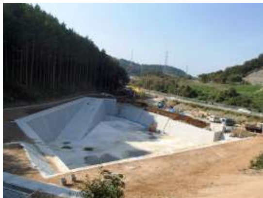
雨水洪水調節池
