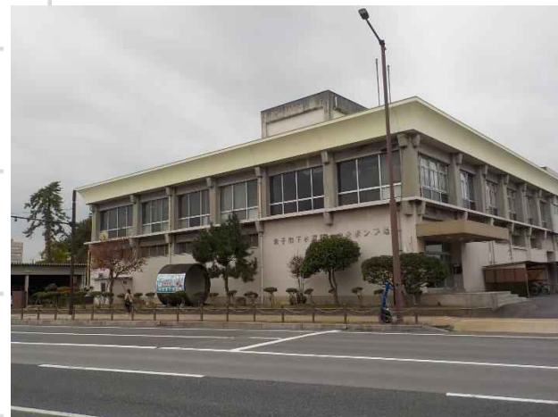
中央ポンプ場 (下水道部事務所)
