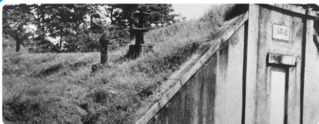
昭和20年頃の配水池入口
