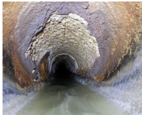
管渠の老朽化対策(TVカメラ調査)
