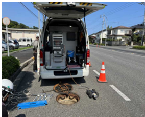
管渠の老朽化対策(TVカメラ調査)
