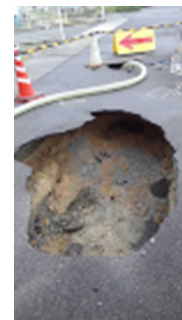
管の破損による 道路陥没
