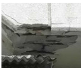
CO剥離・鉄筋むき出し
