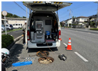
管渠の老朽化対策（TVカメラ調査）
