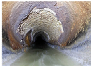
管渠の老朽化対策（TVカメラ調査）
