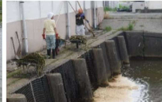
スクリーンの除塵作業
