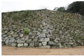
右側隅角部 鎬出角
