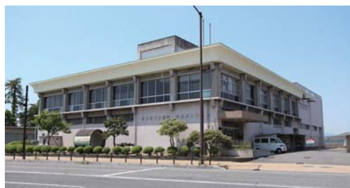
中央ポンプ場（内町）
