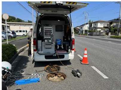
管理の一例（点検状況）
