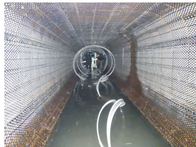
更新（施工状況）
