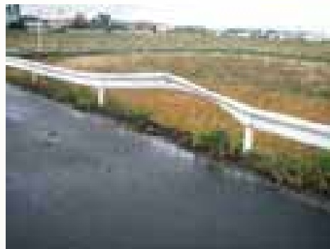
○ガードレール損傷の状況
