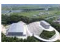
◇新配水池 米子市水道局では、平成28年度の運用開始をめざし、宗像・長砂・観音寺にまたがる丘陵上に、新たな配水池設置事業を進めています。自然流下方式による配水で、有効容量は、中央配水池16,000立方メートル、南部配水池1,800立方メートル。水道用ステンレス鋼製角型配水池としては、国内最大規模となります。【よなごの宝88選実行委員会】
