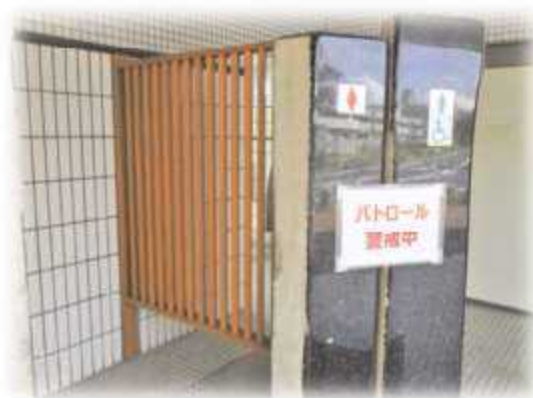
【対策施工後のトイレの様子】
