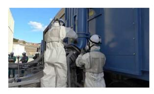
原子炉補機代替冷却系(移動式代替熱交換設備)へのホース接続
