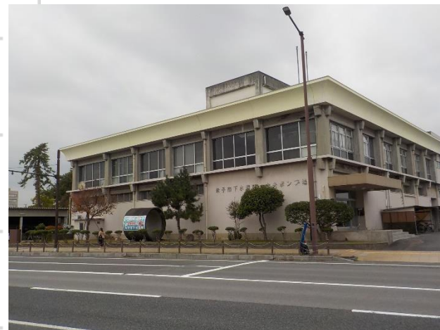
中央ポンプ場 (下水道部事務所)
