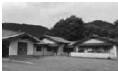
しせつ がいかん 【施設の外観】
