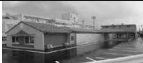
しせつ がいかん 施設の外観
