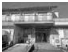
しせつ がいかん 【施設の外観】
