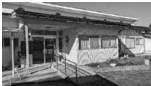
しせつ がいかん 施設の外観
