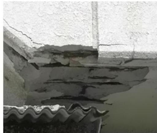
コンクリート剥落・鉄筋の露出
