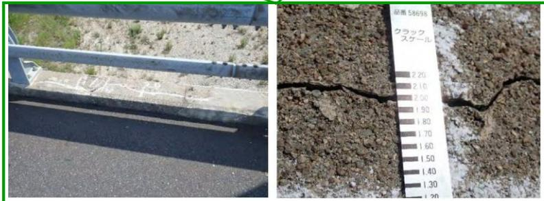
損傷状況：ひびわれ、うき、鉄筋露出
