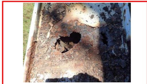
損傷状況：腐食、防食機能の劣化
