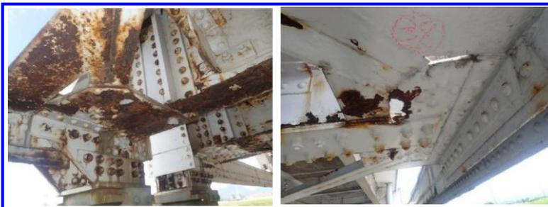
損傷状況：孔食、減肉を伴う腐食、防食機能の劣化
