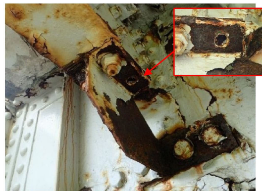
腐食・ボルトの欠損
