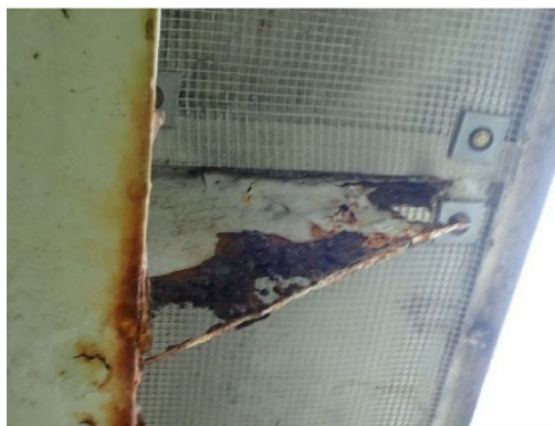
補鋼材の腐食・欠損
