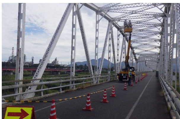
図 2.7-1 鋼部材詳細調査実施状況
