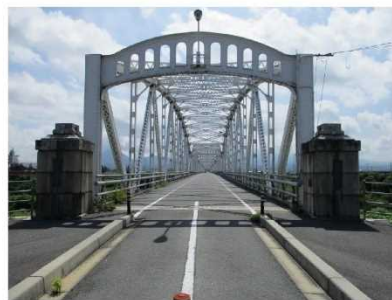
全景(起点側から撮影)
