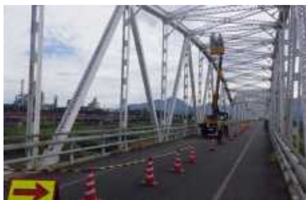
図 2.7-1 鋼部材詳細調査実施状況
