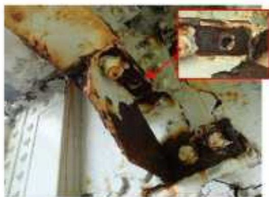
腐食・ボルトの欠損
