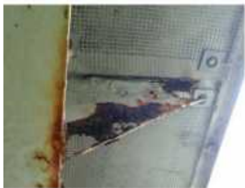
補鋼材の腐食・欠損
