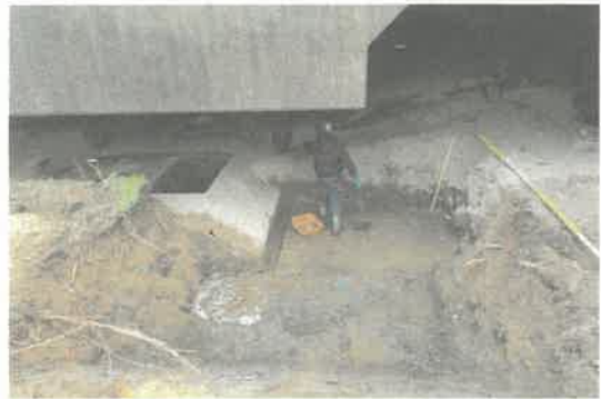
1号飛行機用掩体前面掘削状況
