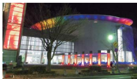
米子コンベンションセンター
