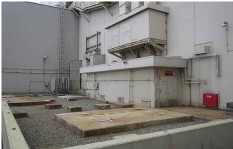
撤去作業後の状況
