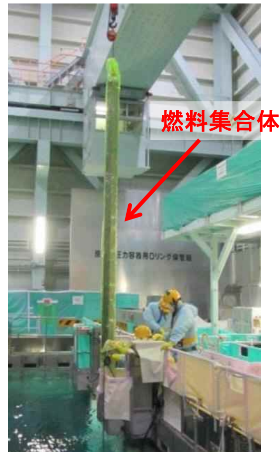
新燃料の引き上げ状況
