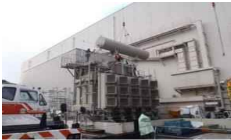
撤去作業の状況
