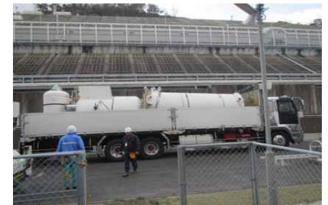
解体物の移送
