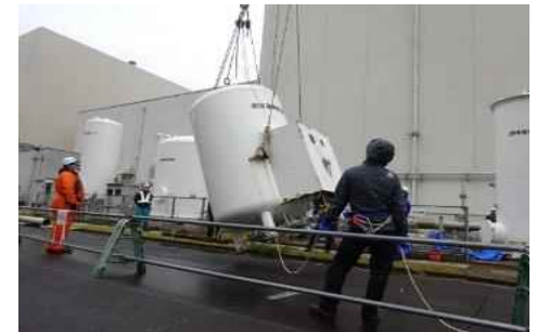
撤去作業の状況
