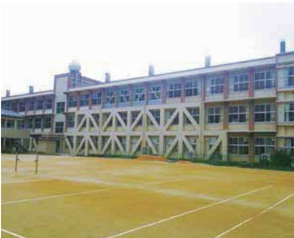
湊山中学校校舎耐震補強事業
