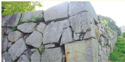
石垣がひび割れたりずれたりしている
