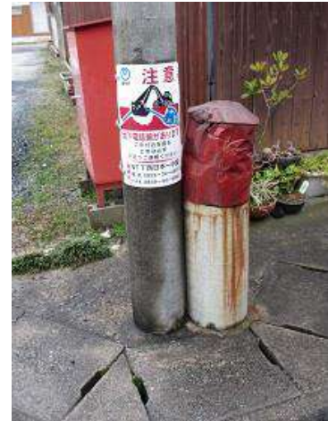
淀江の町中の消火栓
