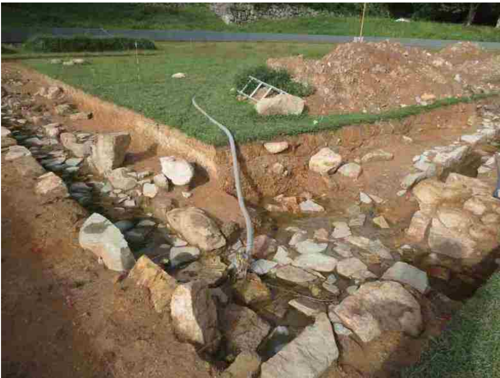
確認された三の丸の石組石敷水路
