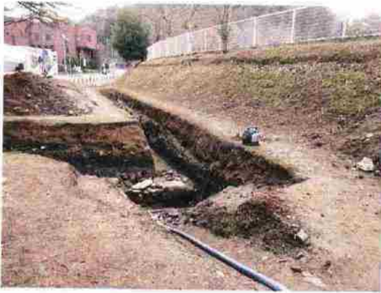
写真1 遠景（北東より）
