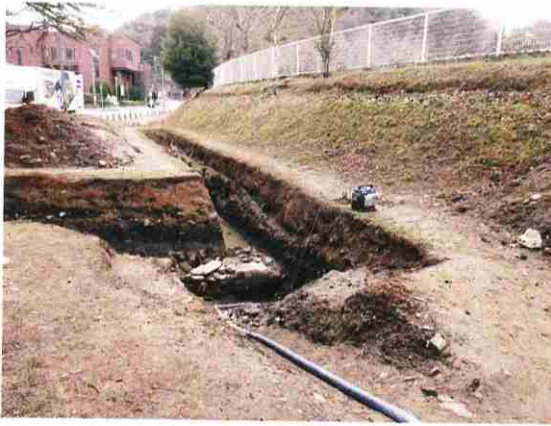
写真1 遠景（北東より）
