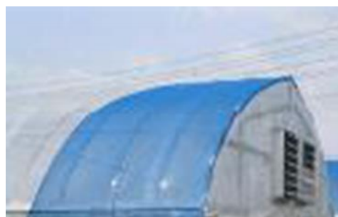
図25 妻面の防風ネットによる補強
