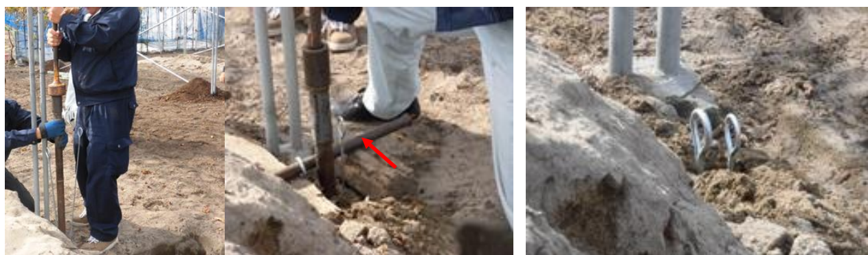
図30 補強に用いるアンカー
