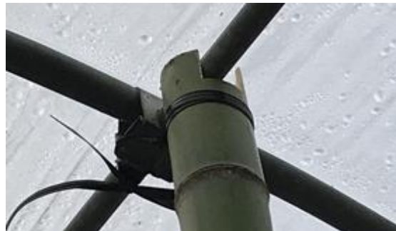
図14 中柱先端の加工と固定
