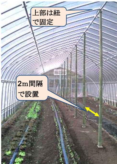
図12 中柱の設置例
