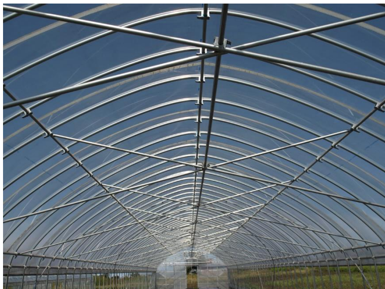
図8 Xタイバーによる補強の事例
