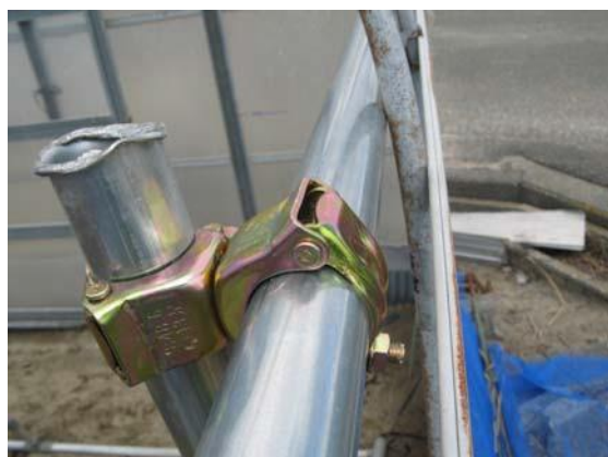
図20 自在クランプによる単管パイプの固定 (静岡県原図)
