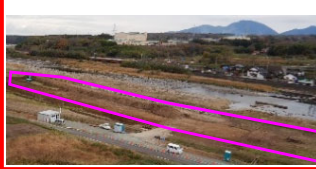
河川改修(日野川)
