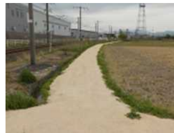
(事例) 真砂土による農道補修
