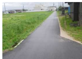
(事例) 農道の舗装
