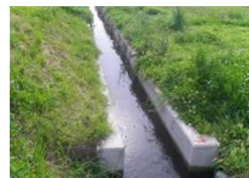
(事例) 農業用水路の改修
